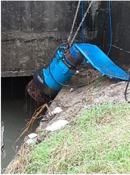
仮設ポンプ(上)
